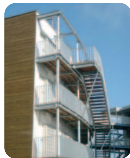
Utilisation d'acier galvanisé et de bardage bois
